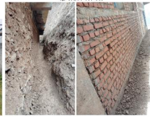
वडा कार्यालय भवन मर्मत
